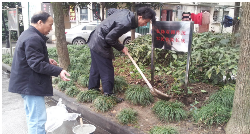
春节后第一个工作日,蓉城的管理员们工作热情高涨。巡视小区得知居委会有一块铜牌需要安装,管理员小吴和小金挽起袖管,拿来铁锹和水泥,将牌子安装好。(徐丽娜)
